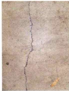
FOTO 3: REPARACION DE PISO TORTA
