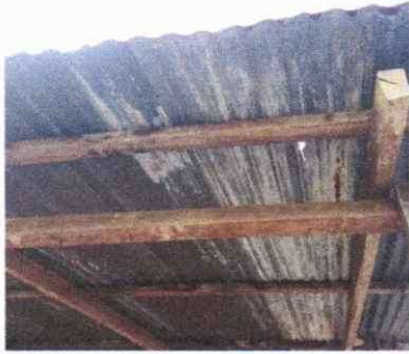
FOTO 1: SUSTITUCION DE LAMINA POR LAMINA TROQUEALDA
