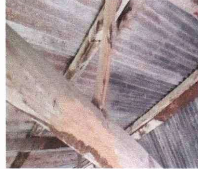
FOTO 2: SUSTITUCION DE ESTRUCTURA DE MADERA POR METAL
