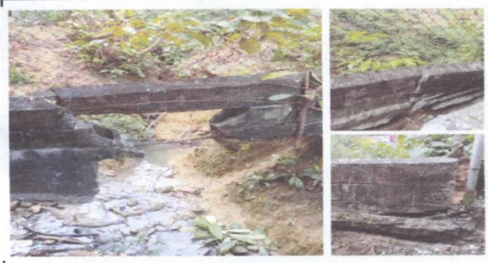
proyecto 4. Reparación de pared de circulación en mal estado
