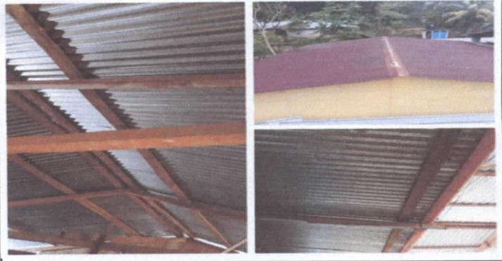
proyecto 2. cambio de laminas antiguas por laminas troqueladas aluzinc y cambio de estructura de mandera a metal.
