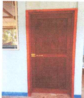
FOTO 8: SUSTITUCIÓN DE PUERTAS
