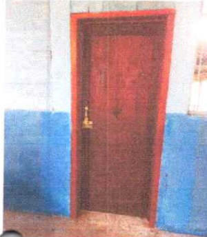
FOTO 7: SUSTITUCIÓN DE PUERTAS
