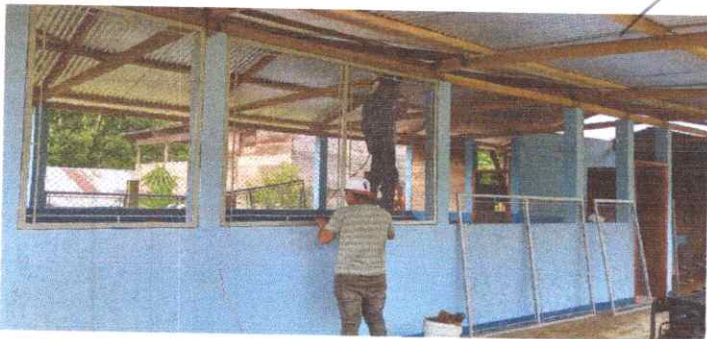
FOTO 5: Sustitución de Ventana
