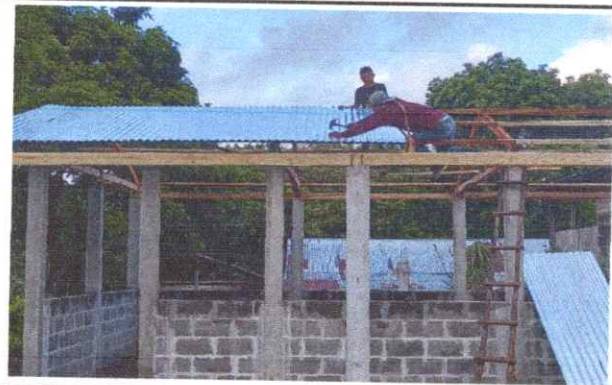
FOTO 4 : Sustitución de Láminas
