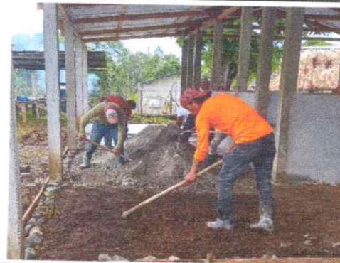
FOTO 6: Reparación de Piso
