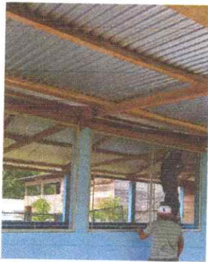
FOTO 3: Sustitución de Ventana
