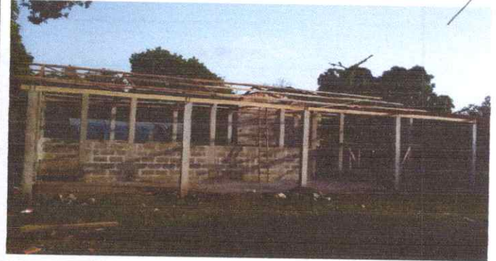
FOTO 2: Sustitución de Estructura de Madera deteriorada por Madera Nueva
