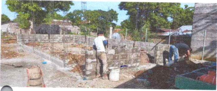
FOTO 1: Sustitución de Horcones y Paredes de Madera por Columnas de Concreto y Paredes de Block
