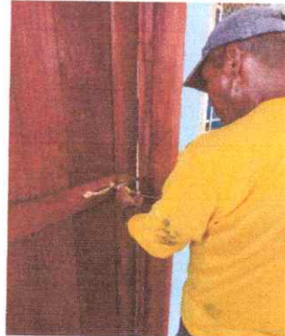
FOTO 8: Sustitución de Puertas
