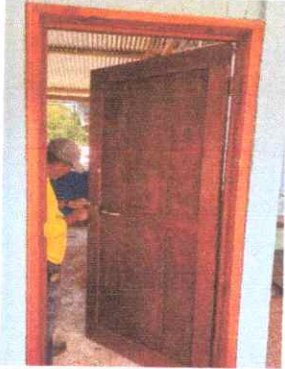
FOTO 7: Sustitución de Puertas
