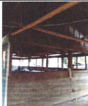
FOTO 3: Se observan estructuras de madera de ventanas y techo que necesitan sustitución
