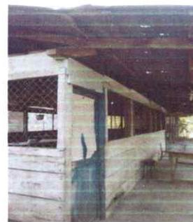
FOTO 6: Al momento de realizar los trabajos de sustitución de paredes es obligatorio reparar el piso de torta de concreto
