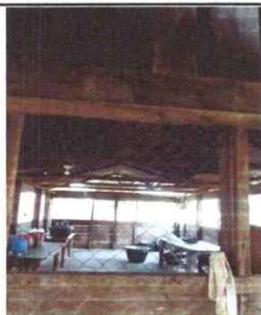
FOTO 5: Se observa ventanas de cocina con malla, necesita sustitución los marcos y las mismas mallas
