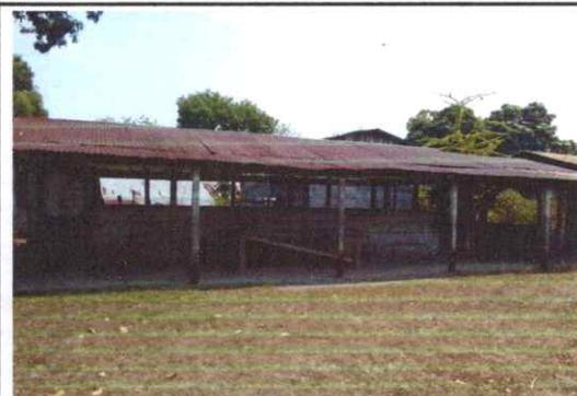
FOTO 2: Se observan láminas de cocina muy oxidados en su totalidad y necesita sustitución
