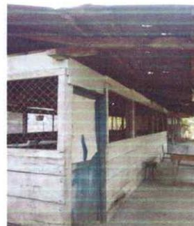
FOTO 4: Se puede observar en la imagen las condiciones de las láminas y madera de estructura de techo deteriorados
