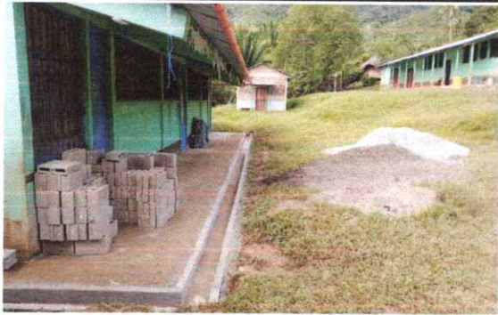
FOTO 1: INSTALACION DE CUNETETA
