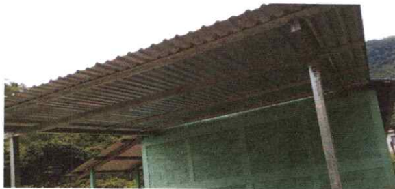
FOTO 9: INSTALACION DE LAMINA TROQUELADA CAL. 26
