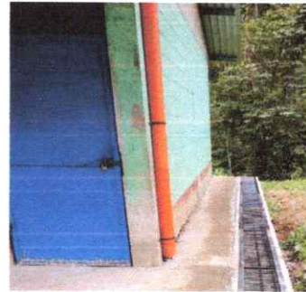
FOTO 4: INSTALACION DE CANALES PARA AGUA PLUVIAL
