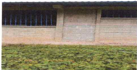
FOTO 7: SELLADO DE VENTANA
