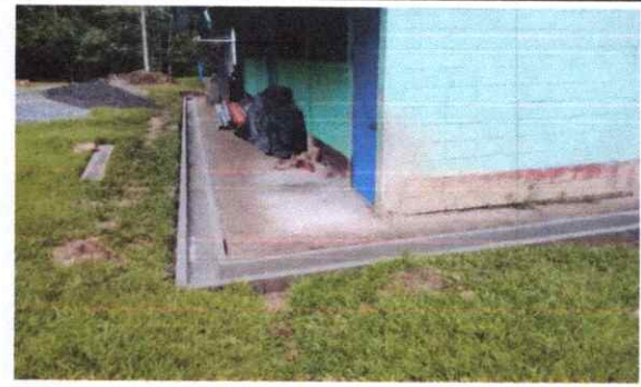
FOTO 2: INSTALACION DE CUNETETA
