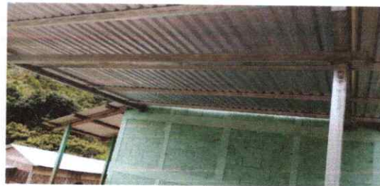
FOTO 8: ESTRUCTURA DE METAL PARA SOPORTE DE TECHO
