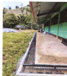
FOTO 10: INSTALACION DE PARRILLA PARA CUNETA
