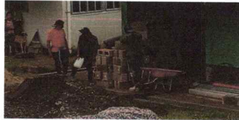
FOTO 2: INSTALACION DE CUNETA
