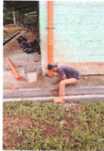
FOTO 3: INSTALACION DE CANALES PARA AGUA PLUVIAL
