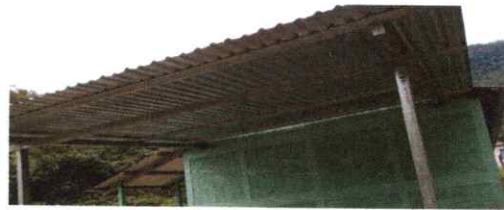
FOTO 10: INSTALACION DE LAMINA TROQUELADA CAL.26
