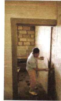
FOTO 8: HABILITACION DE PUERTA EN DIVISION
