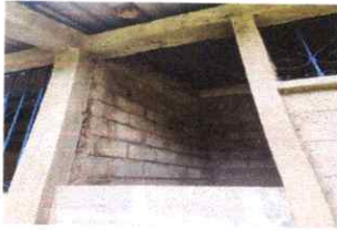
FOTO 7: SELLADO DE VENTANA
