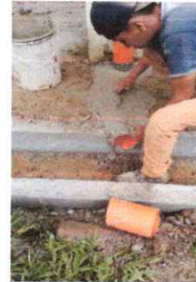
FOTO 4: INSTALACION DE CANALES PARA AGUA PLUVIAL
