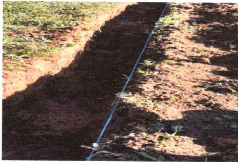
FOTO 1: INSTALACION DE CUNETA
