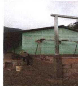
FOTO 6: CONSTRUCCION DE ESCENARIO
