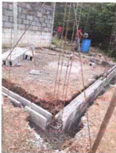
FOTO 5: CONSTRUCCION DE ESCENARIO
