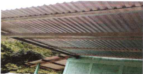
FOTO 11: INSTALACION DE LAMINA TROQUELADA CAL.26
