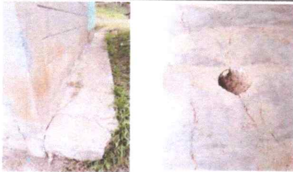
FOTO 3: REPARACION DE PISO TORTA DE CONCRETO
