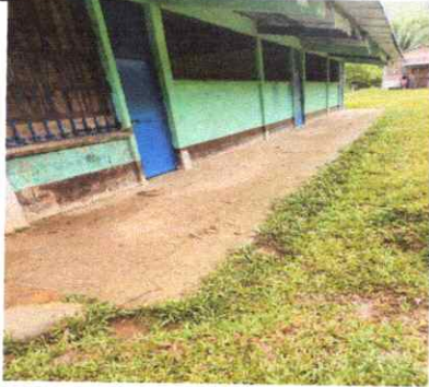
FOTO 1: INSTALACION DE CUNETA
