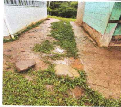
FOTO 2: INSTALACION DE CUNETA
