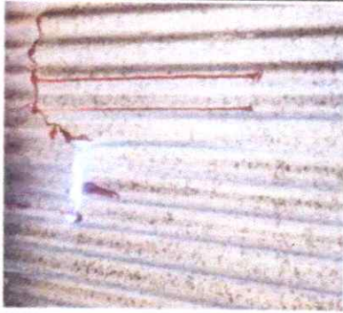
FOTO 1: SUSTITUCION DE LAMINA POR LAMINA TROQUELADA CAL. 26
