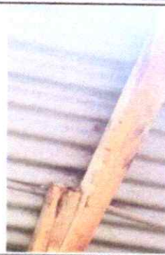
FOTO 2: SUSTITUCION DE ESTRUCTURA DE MADERA POR METAL
