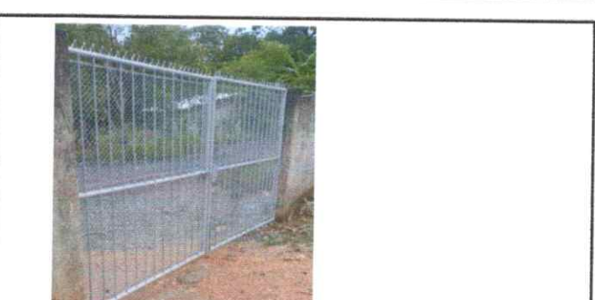
FOTO 6: Mantenimiento a Portón de Metal.
