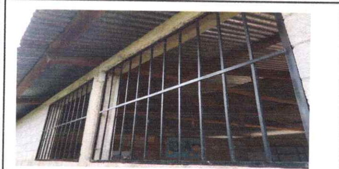
FOTO 1: Sustrucción de Ventana por Metal
