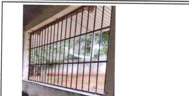
FOTO 2: Sustrucción de Ventana por Metal
