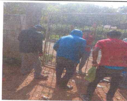
FOTO 6. Mantenimiento a Portón de Metal.
