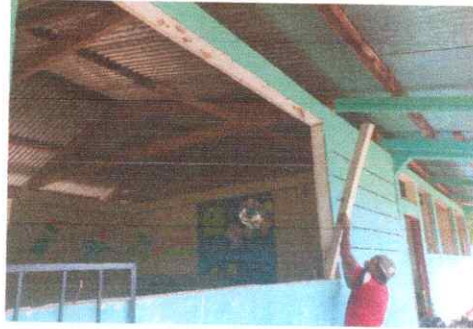
FOTO 2: Sustitución de ventana de madera por metal.
