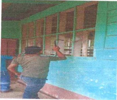
FOTO 1: Sustitucion de ventana de madera por metal
