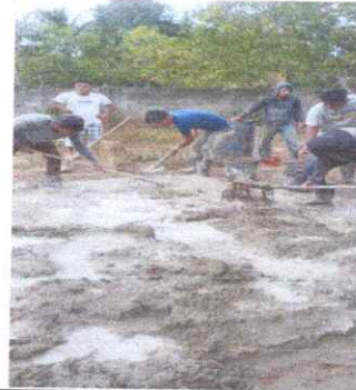
FOTO 4: Sustitución de Piso de torta de concreto.
