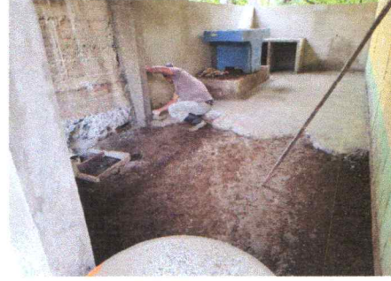
Foto 2: REPARACIÓN DE PISO DE TORTA DE CONCRETO
