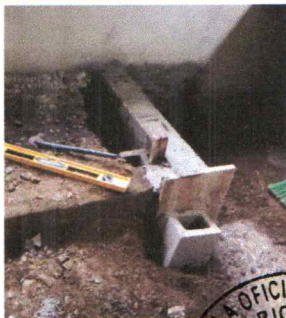
Foto 5: MANTENIMIENTO DE ESTUFA RURAL
