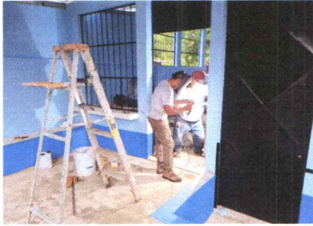
Foto 3: SUSTITUCIÓN DE PUERTA
