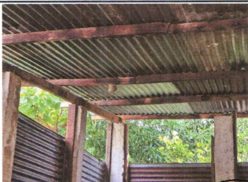
Foto 5: Sustrucción de estructura de madera por metal
