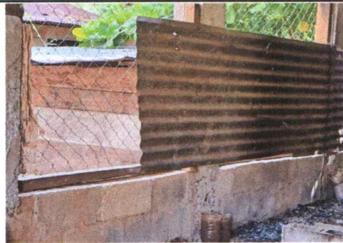
Foto 6: Sustrucción e instalación de metal mas malla
