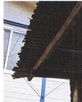
Foto 4: Sustrucción de estructura de madera por metal
