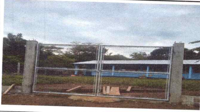
FOTO 1: SE CONSTANTA LA CULMINACION DE LA INSTALACIÓN DE PORTON .
