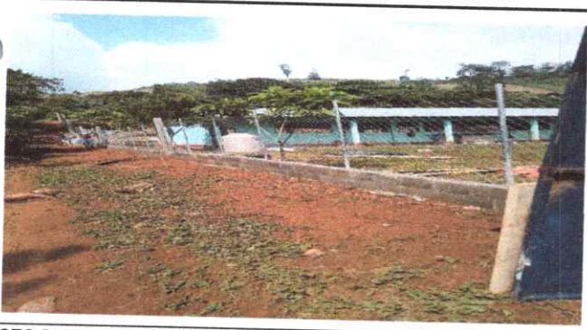
FOTO 5: SE OBSERVA LA CULMINACION BASADO A LA INSTALACIÓN DE MALLA DE CIRCULACION.
