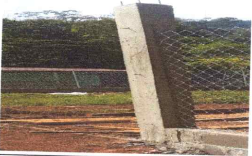
FOTO 4: SE OBSERVA LA CULMINACION ACORDE EL LEVANTAMIENTO DE COLUMNAS DE CONCRETO
