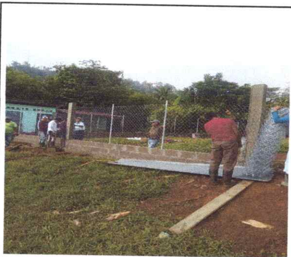
Foto 5: SE OBSERVA LA INSTALACION DE MALLA DE CIRCULACIÓN.
