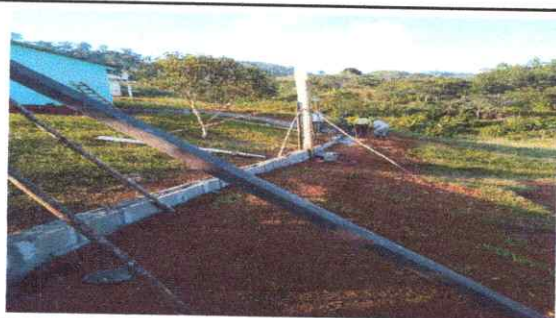
FOTO 3. SE OBSERVA LA SUSTITUCION DE COLUMNAS E INSTALACION DE MALLA
