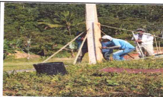
FOTO 4: SE OBSERVA LA REPARACION DE COLUMNAS DE CONCRETO
