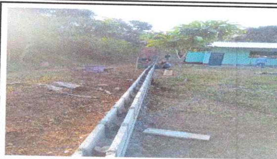
FOTO 2: SE ONSERBA EL LEVANTAMIENTO DE MURO.
