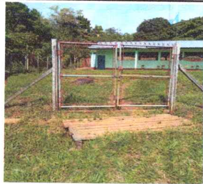
FOTO 4: Sustitución de puerta de malla a puerta de metal.
