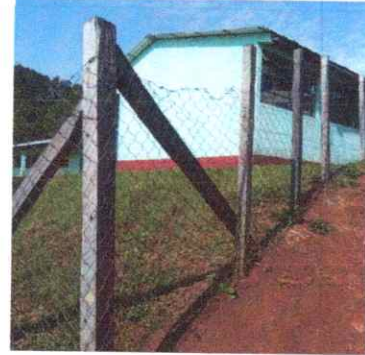
FOTO 2: Sustitución de malla
