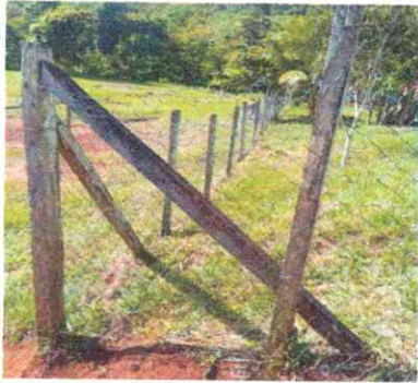
FOTO 3: Sustitución de malla
