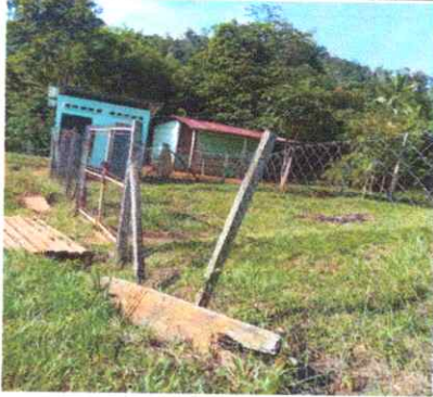
FOTO 1: Sustitución de bases de madera a metal
