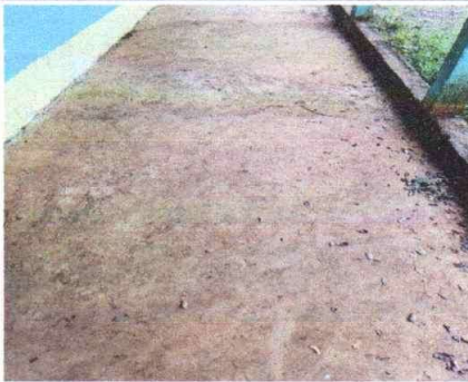
Foto 3: Sustitución de piso de torta de concreto
