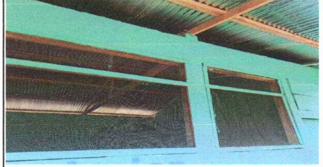
Foto 2: Sustitución de balcones de madera por metal.
