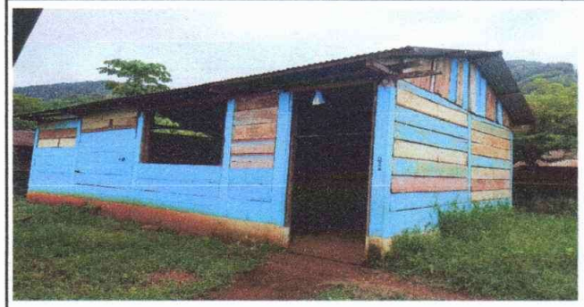
Foto 4: Pintura en muros exterior e interior
