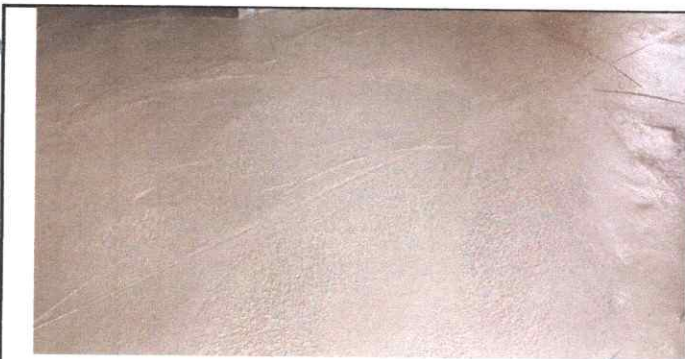
FOTO 5: SUSTITUCIÓN DE PISO DE CONCRETO.
