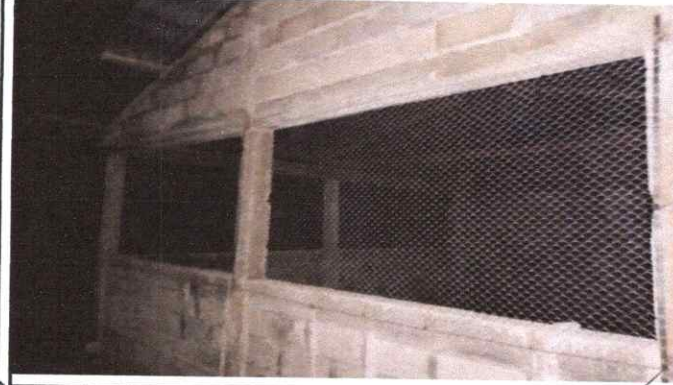
FOTO 1: LEVANTAMIENTO DE COLUMNAS DE CONCRETO
