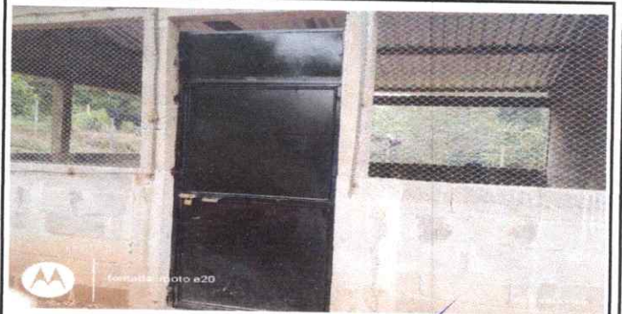
FOTO 4: SUSTITUCIÓN DE PUERTAS DE METAL.
