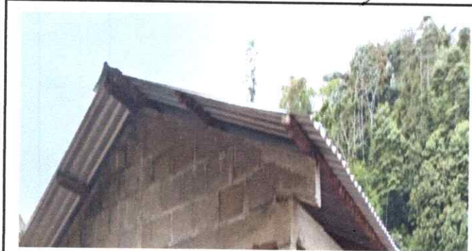
FOTO 3: SUSTITUCIÓN DE LAMINAS
