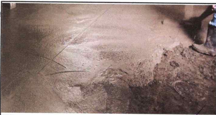
FOTO 5. SUSTITUCIÓN DE PISO DE CONCRETO.
