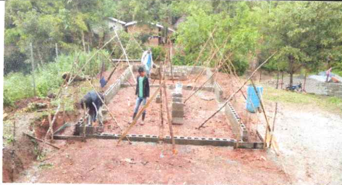
FOTO 1: LEVANTAMIENTO DE COLUMNAS DE CONCRETO.
