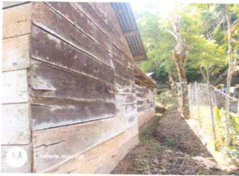
Foto 5: Pintura en muros exteriores e inferiores
