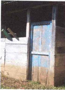
Foto 3: Sustrucción de puertas
