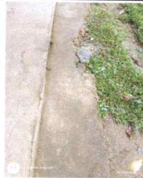
Foto 6: Reparación de piso de concreto de patio
