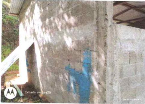
Foto 7: Repello en muros de pared
