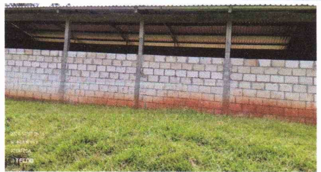
Foto 4: Aplicación de repello de muro de contención
