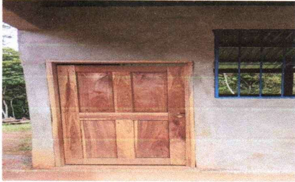
Foto 1: Sustitución de puerta de mandera por metal
