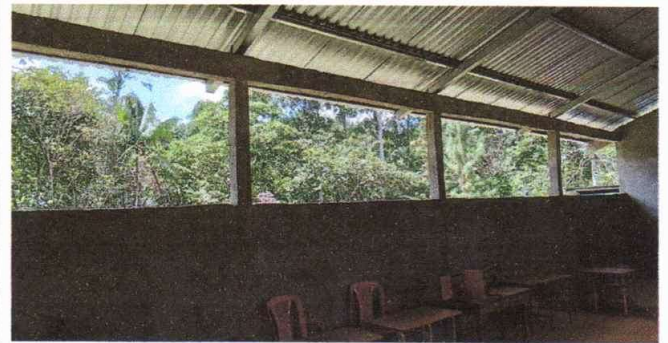
Foto 2: Sustitución de balcones de metal
