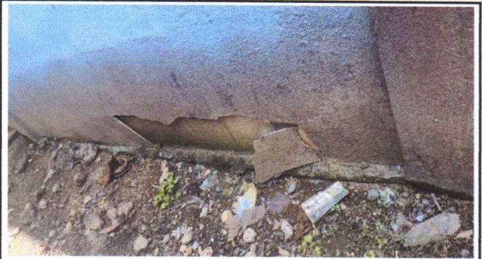
Foto 4: Sellado de grietas y fisuras en muros.
