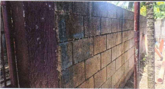
Foto 3: Repello en muro.
