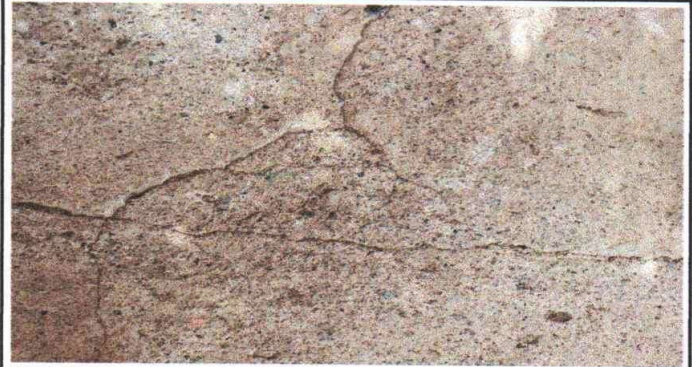
Foto 2: Reparación de piso de torta de concreto-
