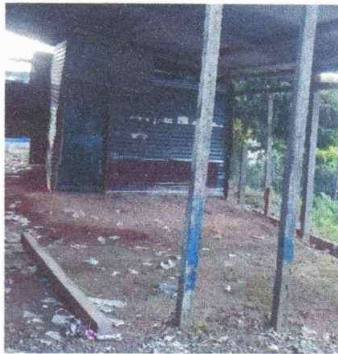
Foto 3 REPARACION DE PISO DE TORTA DE CONCRETO
