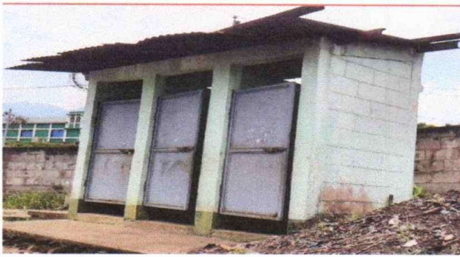
Foto 3: Mantenimiento de Puertas Sanitarias.
