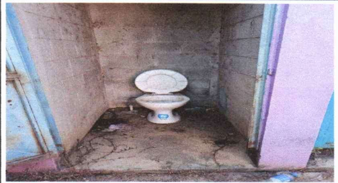
Foto 4: Sustitución de Inodoro Sanitario.
