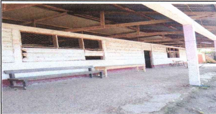
Foto 5: Pintura en muros exteriores de las aulas.
