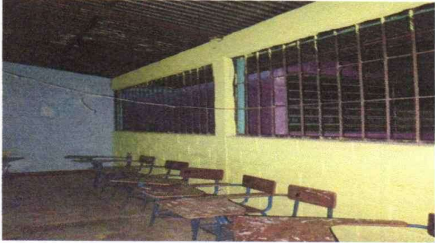
Foto 1: Reparación de Cableado Eléctrico.
