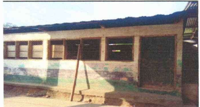
Foto 4: Sustitución de ventanas de madera por metal mas vidrio
