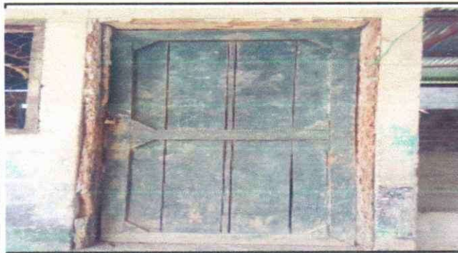
Foto 3: Sustitución de puerta
