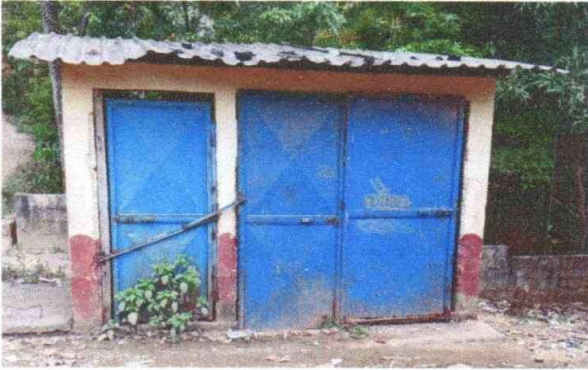
Foto 1: Sustitución de Puertas
