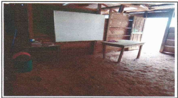
Foto 4: sustitución de piso torta de cemento
