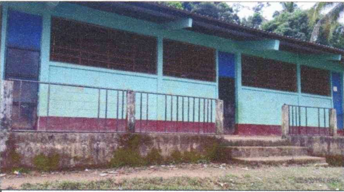
foto 3: sustitución de barandal de corredor
