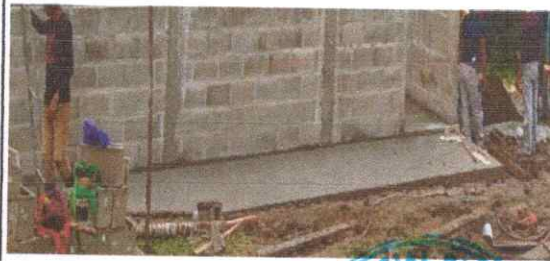
Foto 6: SUSTITUCIÓN DE BANQUETAS DE CONCRETO
