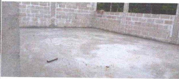
Foto 5: SUSTITUCIÓN DE PISO DE TORTA DE CONCRETO
