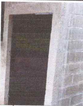
Foto 3: SUSTITUCIÓN DE PUERTAS
