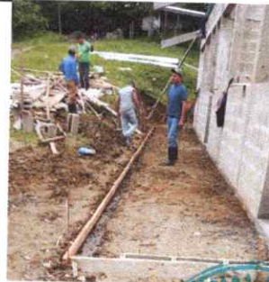
Foto 6: SUSTITUCIÓN DE BANQUETAS DE CONCRETO
