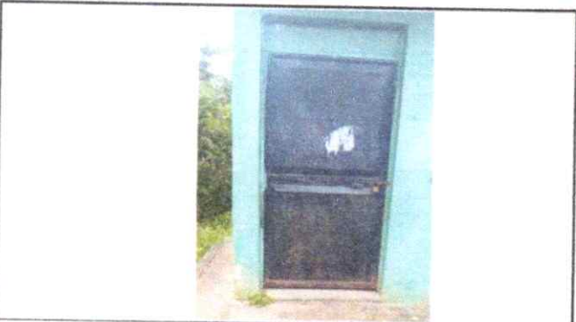
Foto 3: Sustitución de puerta
