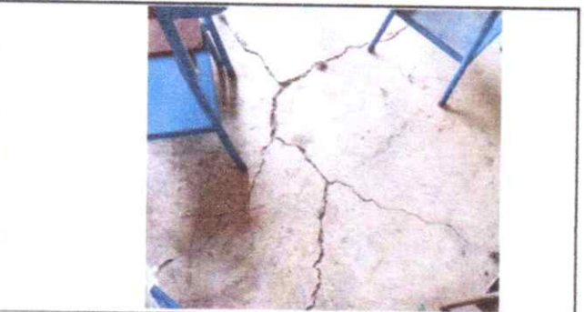
Foto 5: Sustitución de piso de torta de concreto
