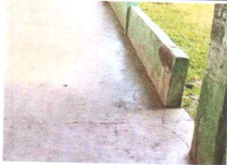
Foto 6: Reparación de banquetas de concreto
