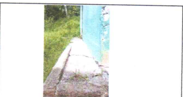
Foto 6: Reparación de banquetas de concreto
