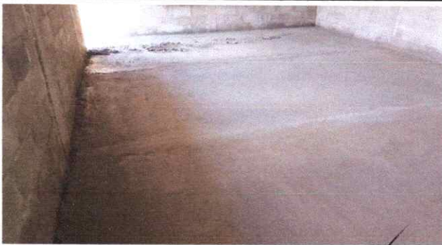
FOTO 3: Sustitución de piso de torta de concreto. Aula.
