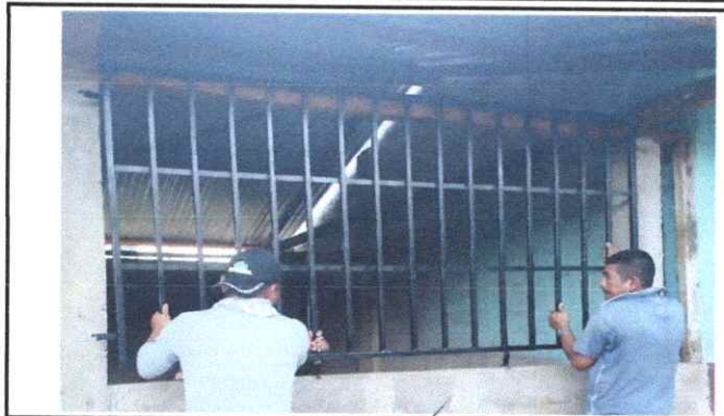
FOTO 2: Sustitución de balcones de metal.
