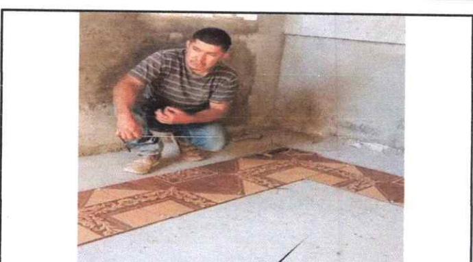
FOTO 4: Sustrucción de piso cerámico.
