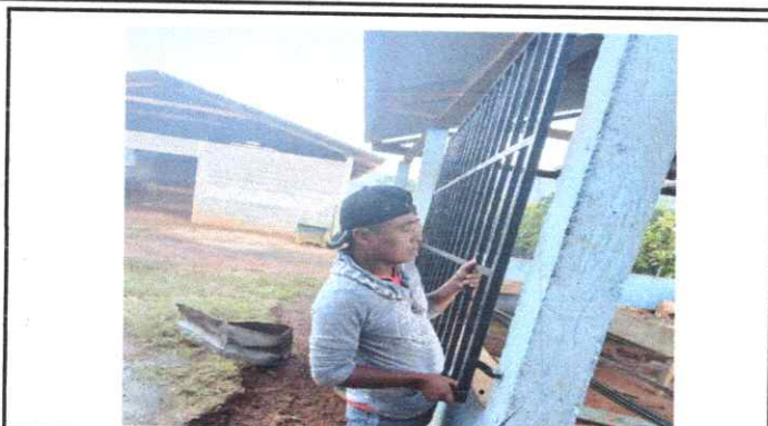
FOTO 2: Sustrucción de balcones de metal.
