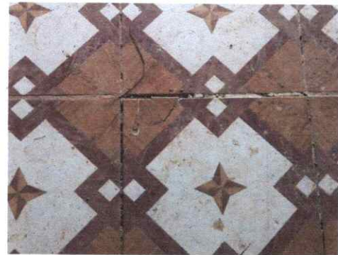
FOTO 4: Sustitución de piso cerámico.
