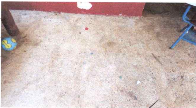
FOTO 3: Sustitución de piso de torta de concreto.
