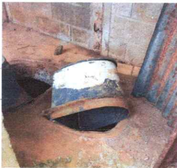
FOTO 5: Sustitucion de inodoro
