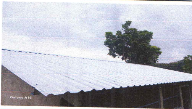
FOTO 4: INSTALACIÓN DE LAMINA TROQUELADA.
