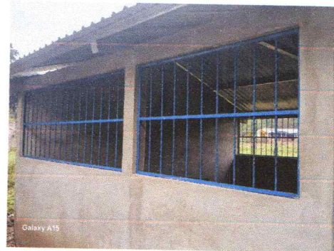
FOTO 5: FABRICACIÓN E INSTALACIÓN DE BALCONES.
