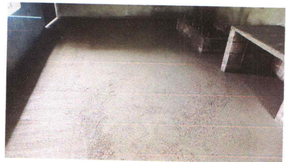
FOTO 6: SUSTITUCIÓN DE PISO DE TORTA
