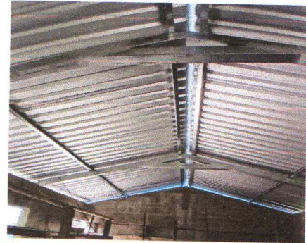
FOTO 2: INSTALACIÓN DE ESTRUCTURAS METÁLICAS.
