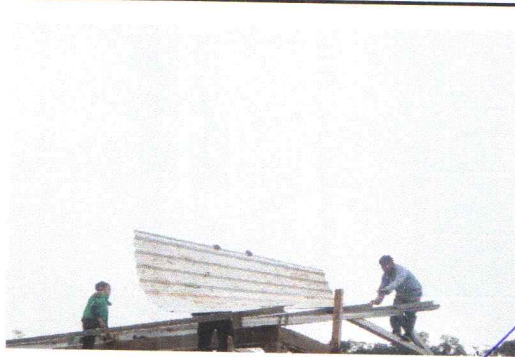
FOTO 4: INSTALACIÓN DE LAMINA TROQUELADA.
