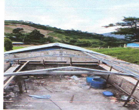
FOTO 2: INSTALACIÓN DE ESTRUCTURAS METÁLICAS.
