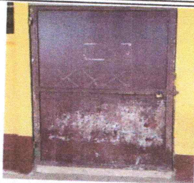
Foto 1: Sustitución de puerta
