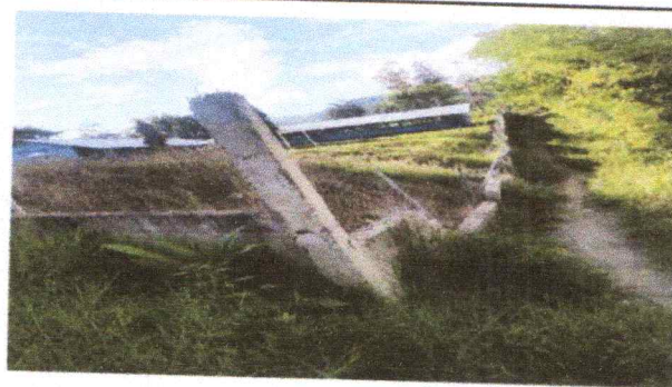
Foto 4: Reparación de muro perimetral de block con tubo hg y malla galvanizada, soleras intermedias y columnas.
