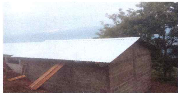
Foto 4: INSTALACION DE LÁMINAS TROQUELADAS
