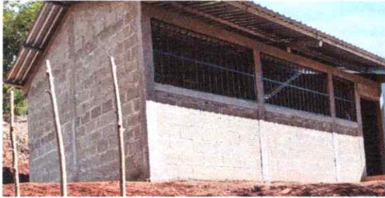
Foto 1: CONSTRUCCION DE PAREDES
