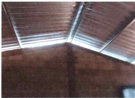
Foto 3: FABRICACION DE ESTRUCTURA DE SOPORTE DE TECHO
