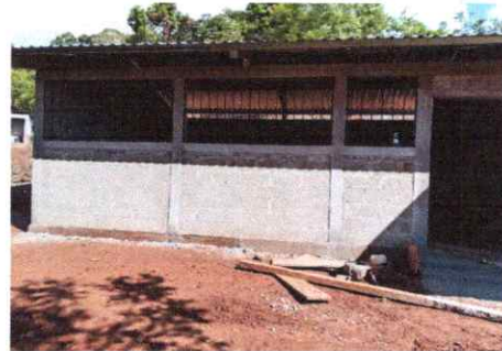
Foto 2: CONSTRUCCION DE VIGAS Y COLUMNAS
