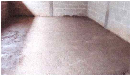
Foto 5: FUNDICION DE PISO DE TORTA DE CONCRETO
