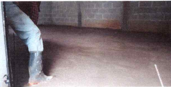
Foto 5: FUNDICION DE PISO DE TORTA DE CONCRETO
