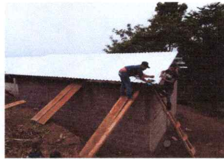
Foto 4: INSTALACION DE LÁMINAS TROQUELADAS
