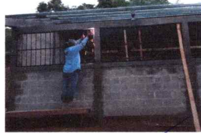
Foto 6: INSTALACION DE BALCONES DE METAL.
