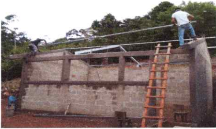
Foto 3: FABRICACION DE ESTRUCTURA DE SOPORTE DE TECHO
