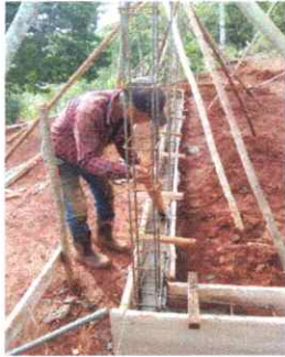
Foto1: CONSTRUCCION DE PAREDES
