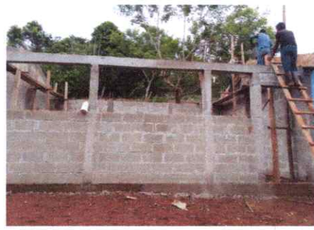
Foto 2: CONSTRUCCION DE VIGAS Y COLUMNAS
