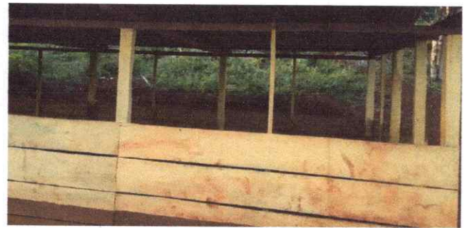
Foto 4: Sustitución de ventanas de madera por metal mas vidrio
