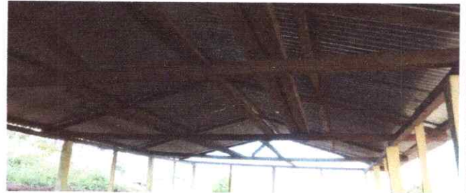
Foto 2: Sustitución de estructura de soporte de madera, por metal
