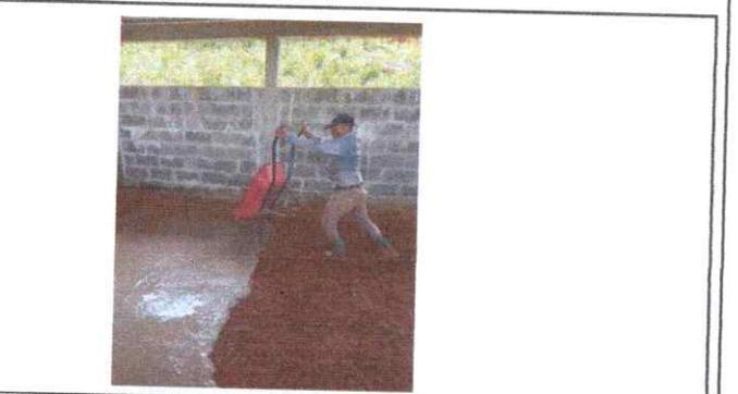
FOTO 6: REPARACIÓN DE PISO DE TORTA DE CONCRETO DE COCINA
