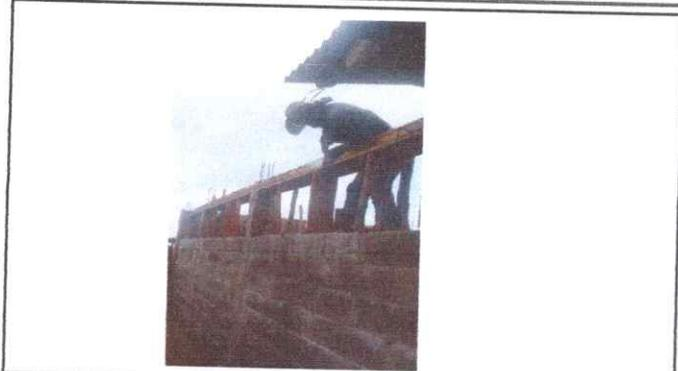
FOTO 2: SUSTITUCIÓN DE PAREDES DE MADERA POR PAREDES DE BLOCK CON CIMENTO
