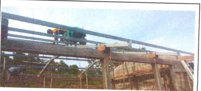
FOTO 3: SUSTITUCIÓN DE LÁMINAS ACTUAL POR LÁMINAS ACANALADA ALUZINC
