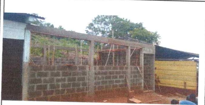
FOTO 1: SUSTITUCIÓN DE HORCONES DE MADERA POR COLUMNAS DE CONCRETO
