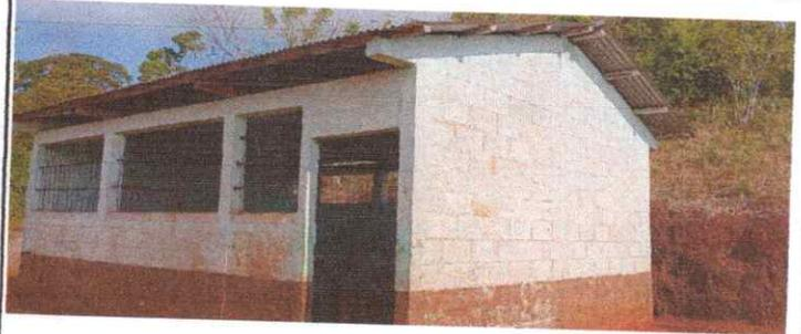
Foto 2: Se puede observar en la imagen las estructuras de soporte de madera y que necesita sustitución
