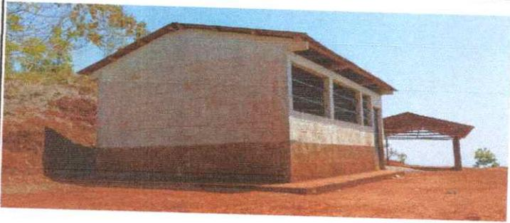
Foto 3: Se puede observar al fondo la cocina de la escuela sin paredes y con horcones de madera
