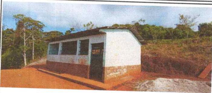
Foto 1: Se puede observar la escuela donde es necesario realizar la sustitución de las láminas acanaladas por troqueladas calibre 26
