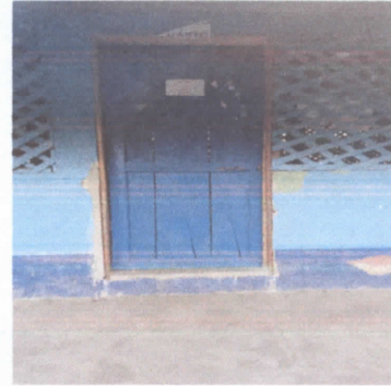
FOTO 2: Sustitucion de puerta
