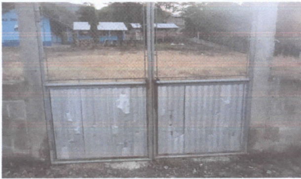
FOTO 3: Mantenimiento porton de metal
