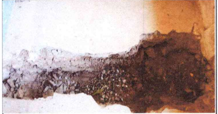
SUSTITUCION DEN PISO DE TORTA DE CEMENTO DE CONCRETO
