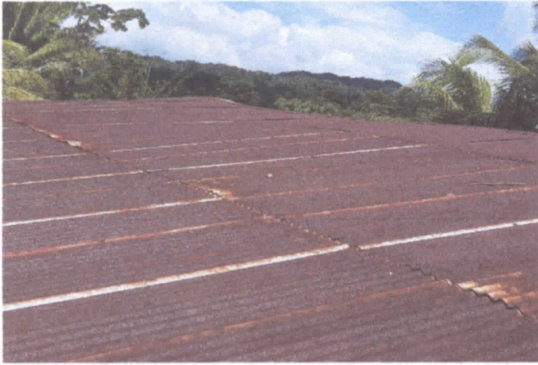
1.1 Sustitución de lámina, por lámina troquelada aluzinc calibre 26,
