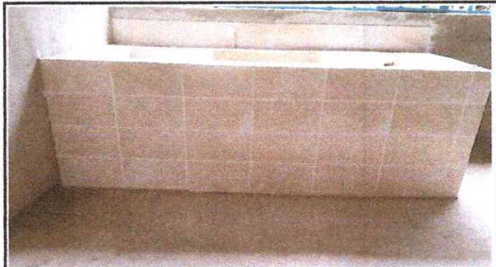
FOTO 4: Sustitución de pila de cemento de dos lavadero
