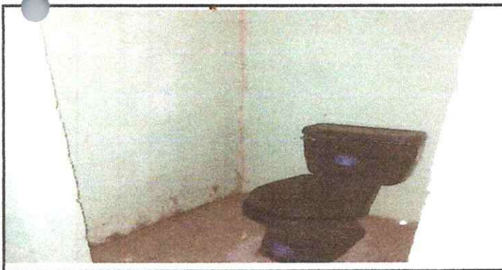
FOTO 5: Sustitución inodoro Y Reparación de Muros de baños
