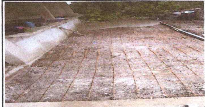
FOTO 6: Sustrucción de piso de torta de concreto
