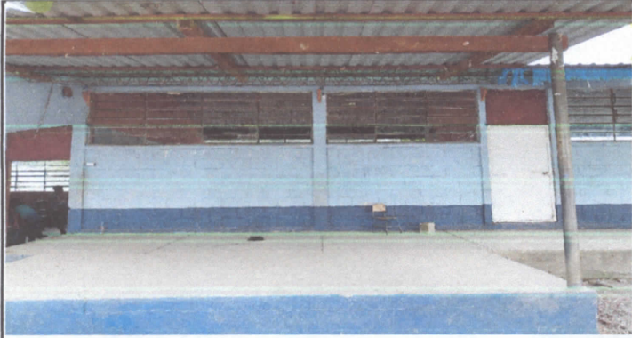
Sustitución de Balcones de metal
