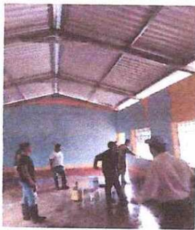
FOTO 3: PINTURA MURO INTERIOR Y EXTERIOR
