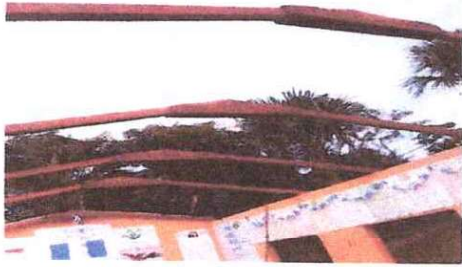
FOTO 1: SUSTITUCION DE ESTRUCTURA DE MADERA POR METAL
