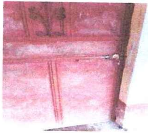
FOTO 1: MANTENIMIENTO DE PUERTAS
