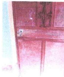
Foto 6: MANTENIMIENTO DE PUERTAS
