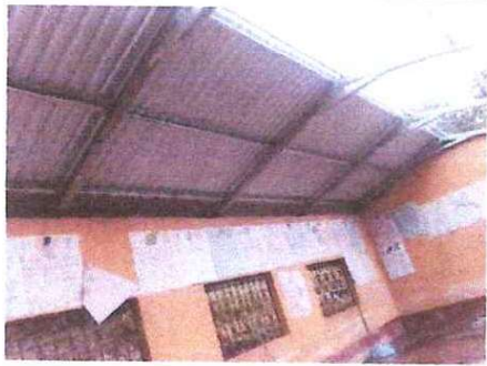
FOTO 3: SUSTITUCION DE LAMINA POR LAMINA TROQUEALDA
