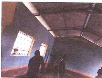
Foto 5: PINTURA MURO INTERIOR Y EXTERIOR
