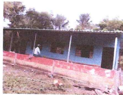
FOTO 4: PINTURA MURO INTERIOR Y EXTERIOR
