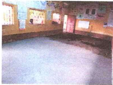
Foto 5: REPARACION DE PISO TORTA
