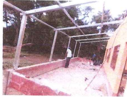
FOTO 2: SUSTITUCION DE ESTRUCTURA DE MADERA POR METAL
