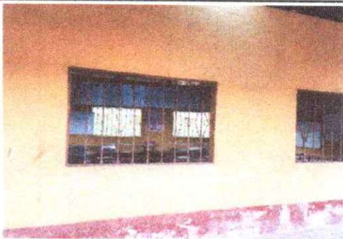
FOTO 5: MANTENIMIENTO DE BALCONES
