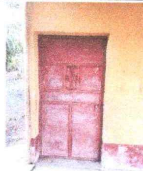
FOTO 4: MANTENIMIENTO A PUERTAS DE METAL
