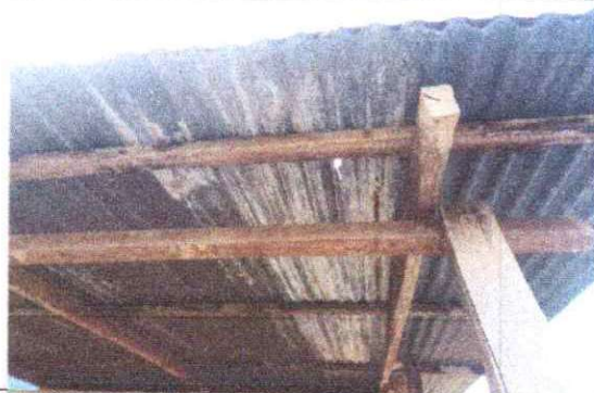
FOTO 2: SUSTITUCION DE ESTRUCTURA DE MADERA POR METAL
