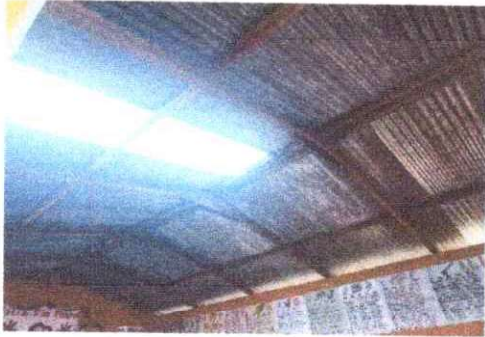
FOTO 1: SUSTITUCION DE LAMINA POR LAMINA TROQUELADA
