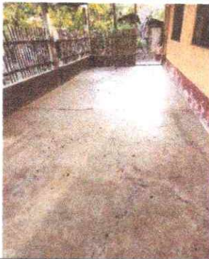
FOTO 3: REPARACION DE PISO TORTA
