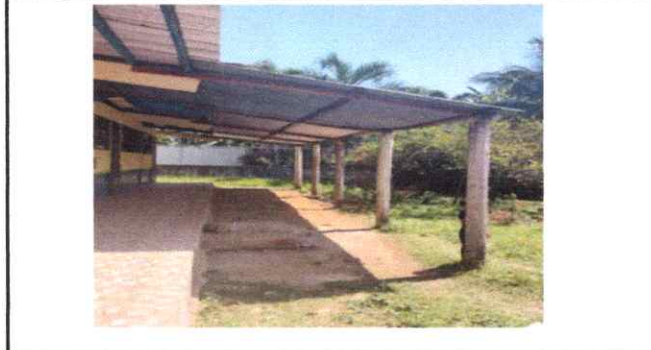
FOTO: FINALIZACIÓN TECHO DE LÁMINA CORREDOR
