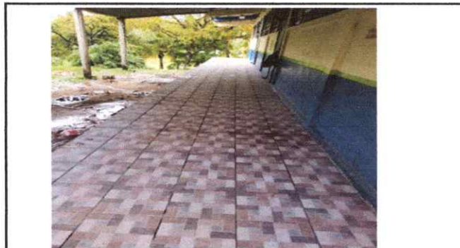
Foto 4: FINALIZACIÓN TORTA DE CEMENTO POR PISO GRANITO
