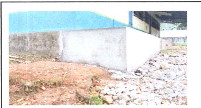
FOTO 3 FINALIZACIÓN DE MURO PEQUEÑO.
