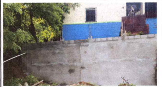
FOTO 1 FINALIZACIÓN MURO DE CONTENCIÓN
