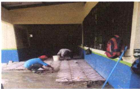
FOTO 5 PROCESO DE SUSTITUCIÓN TORTA DE CEMENTO POR PISO GRANITO.
