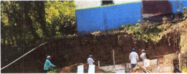
FOTO 1 PROCESO DE TRABAJO MURO DE CONTENCIÓN
