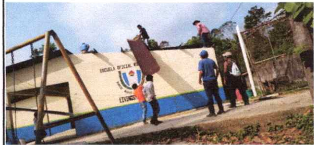
FOTO 6 PROCESO DE SUSTITUCIÓN DE LÁMINA
