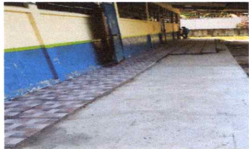
FOTO 4 PROCESO DE SUSTITUCIÓN DE TORTA DE CEMENTO POR PISO GRANITO
