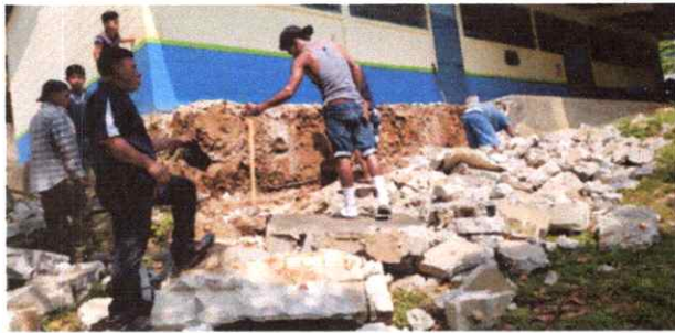
FOTO 3 PROCESO DE SUSTITUCIÓN MURO PEQUEÑO
