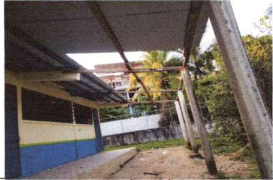
FOTO 2 PROCESO DE SUSTITUCIÓN DE LÁMINA CORREDOR
