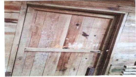
Foto 2: Sustitución de puertas de madera, por puertas de madera.
